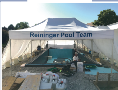
Baustellenzelt für Winterarbeiten
